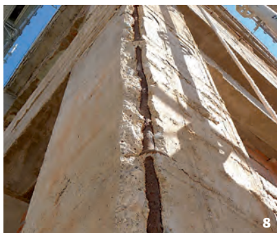
Fig. 8 y 9: desprendimiento del hormigón por corrosión de armaduras en soportes.
