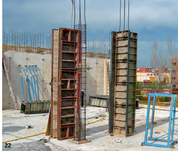
Fig. 21: colocación de separadores en el armado de soportes.
