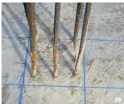
Fig. 19: replanteo del pilar para montaje del encofrado.
