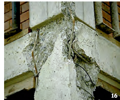
Fig. 16: rotura con pandeo de las armaduras.
