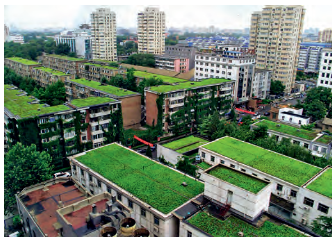
Fig. 5: transformación en Pekín de azoteas transitables a cubiertas ajardinadas para reducir costos energéticos.
