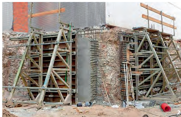
Fig. 1: ejecución muro contención.
