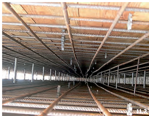
Fig. 11.1 y 11.2: colocación separadores en el armado del muro.
