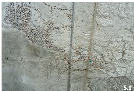
Fig. 5.1 y 5.2: nidos de grava en muros.
