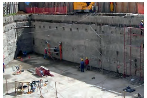
Figura 2: muros pantalla de hormigón armado.
