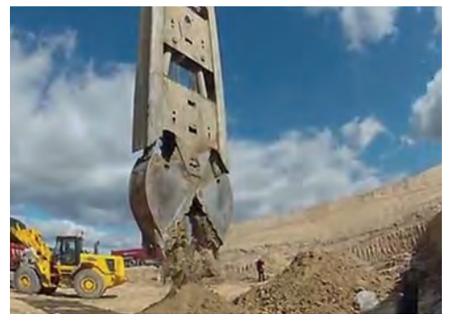
Figura 1: excavación zanja con cuchara bivalva.
