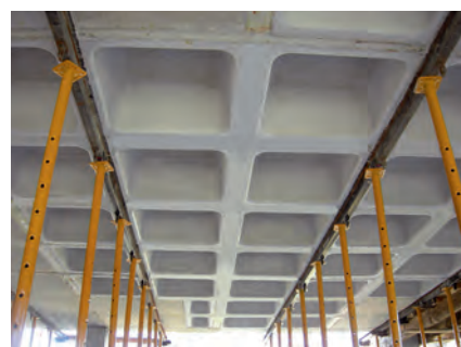
Figura 4: aligeramiento del forjado reticular con moldes recuperables.
