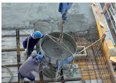
Figura 16: fase de hormigonado: vertido de hormigón con cubilote.
