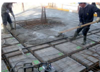
Figura 17: fase de hormigonado: vibrado y extendido del hormigón.
