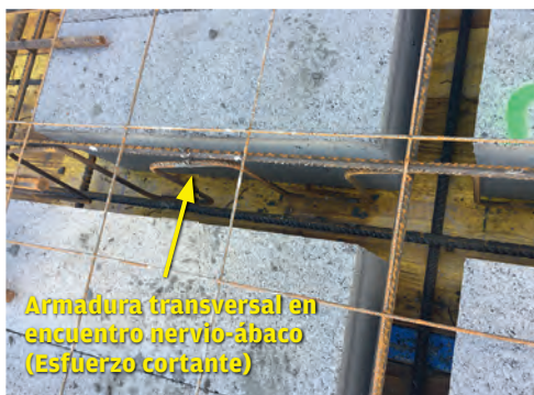
Figuras 11 y 12: armado a esfuerzos cortantes en encuentro nervio-ábaco.
