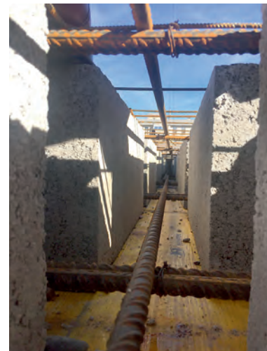
Figura 10: armado de nervios.
