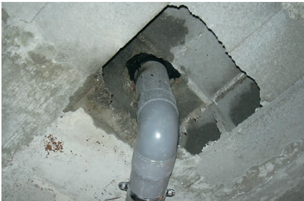
Fig. 1: cazoleta en cubierta plana transitable.
