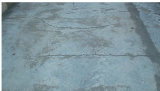
Fig. 1: ejecución solera de hormigón.
