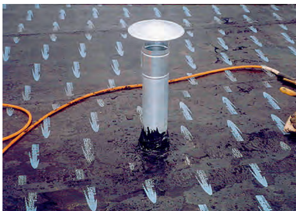
Fig. 1: encuentro con una puerta de acceso a la cubierta.
