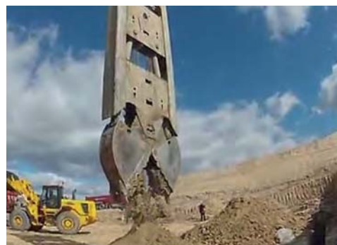
Figura 1: excavación zanja con cuchara bivalva.
