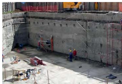
Figura 2: muros pantalla de hormigón armado.
