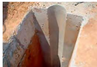
Figura 6: junta de media luna.
