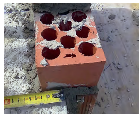
Figura 1: apoyo insuficiente de un ladrillo en borde de forjado.
