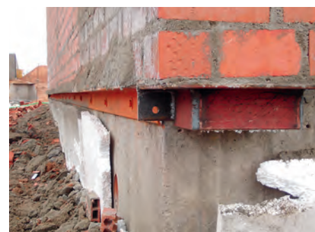
Figura 2: colocación de angulares para apoyo de fábrica en borde.
