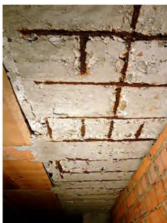
Figura 6: corrosión del armado de una viga. Ausencia de recubrimiento.
