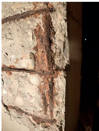
Figura 5: corrosión de las barras corrugadas de un pilar. Condiciones ambientales. Carbonatación.
