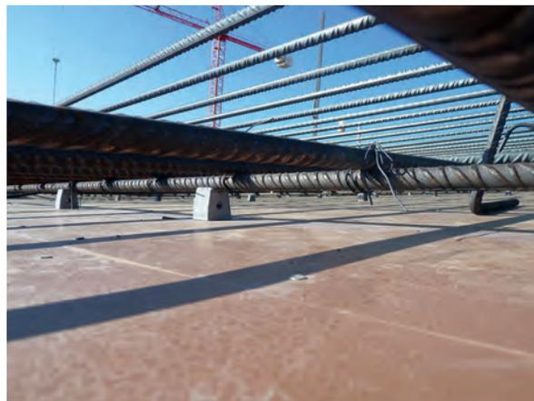
Figura 4: colocación de separadores para garantizar el recubrimiento.
