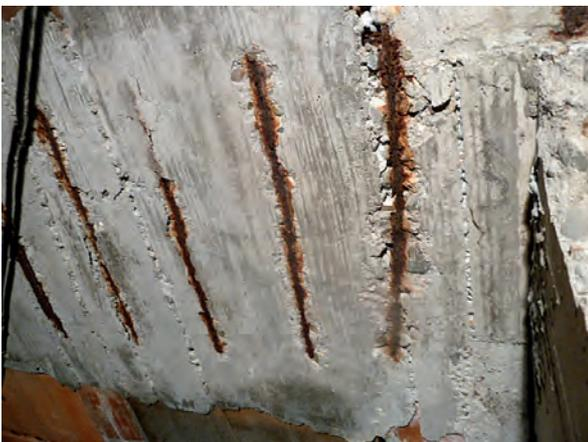
Figura 3: deficiente recubrimiento. Corrosión de la armadura.
