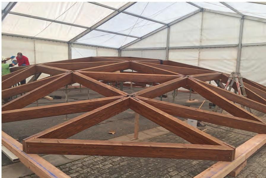
➤ los apoyos se reparten a lo largo de todo el perímetro de los muros de piedra, evitando los soportes puntuales de vigas que ejercerían cargas concentradas elevadas.
