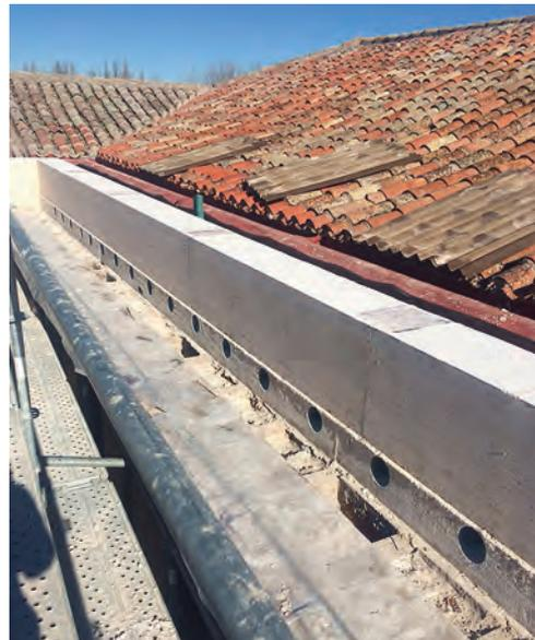
evitando esfuerzos añadidos en los muros del edificio existente.
