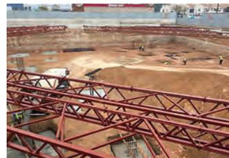
**1** La cimentación se resuelve con zapatas aisladas sobre pozos de cimentación. El arriostramiento entre zapatas se soluciona con una solera de hormigón armado.
