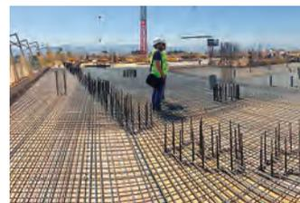
**2** Disposición de contraplacas de arranque de las estalagmitas en el forjado de planta segunda.
