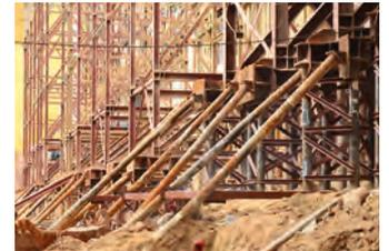
**1** Una vez retirados los elementos a conservar, se ejecutan micropilotes que sirven como estructura de apeo y estabilización de fachadas.
