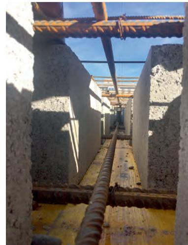
Figura 10: armado de nervios.
