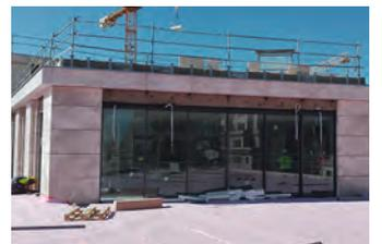
**4** Se retranquean las tres plantas de nueva construcción y se sustituyen los áticos existentes en los diferentes edificios por unas nuevas fachadas.
