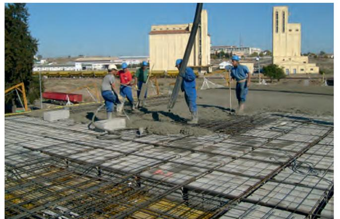
Figura 2: hormigonado de forjado reticular.
