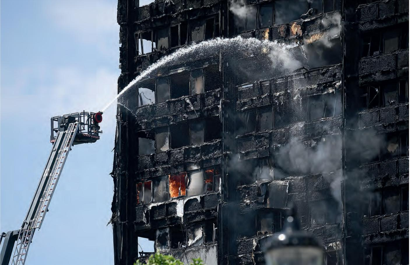
Para satisfacer las exigencias de este Documento Básico, especialmente el de propagación exterior, debemos distinguir entre su resistencia al fuego y su reacción al fuego. La resistencia al fuego mide la capacidad de un sistema constructivo para resistir al fuego y seguir proporcionando la función prevista durante un tiempo determinado en características claves como su capacidad portante (R), la integridad (E) o el aislamiento para detener el paso del calor al lado opuesto (I).
