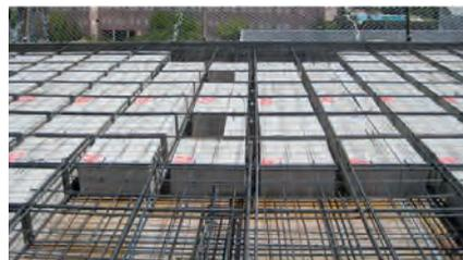
Figura 5: aligeramiento del forjado reticular con moldes permanentes de hormigón.
