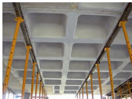
Figura 4: aligeramiento del forjado reticular con moldes recuperables.
