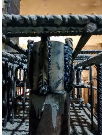
**FIGURA 6** Camisa metálica embebida en encepado provisional.
