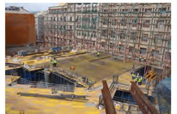
**3** Una vez finalizada la ejecución de la losa de sótano -1, comienza la ejecución convencional de la estructura ascendente.
