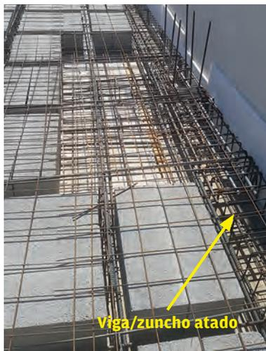
Figura 9: armado de vigas y/o zunchos.
