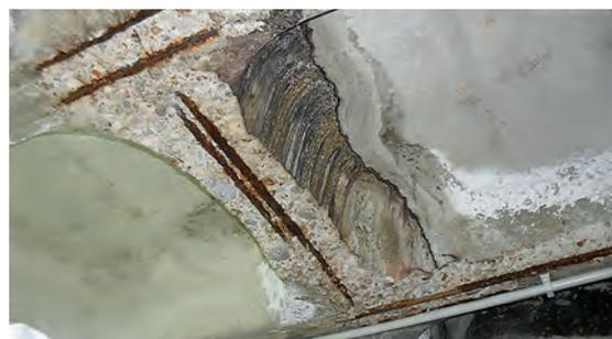
Figura 8: fisuras por corrosión de las armaduras.
