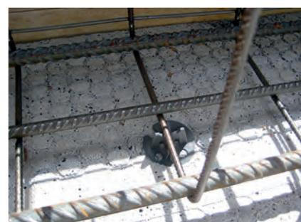
Figura 14: recubrimientos. Colocación de separadores.
