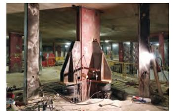
**2** Colocación de los perfiles metálicos que, en conjunto con los tubos de los micropilotes, rigidizan el sistema estructural.
